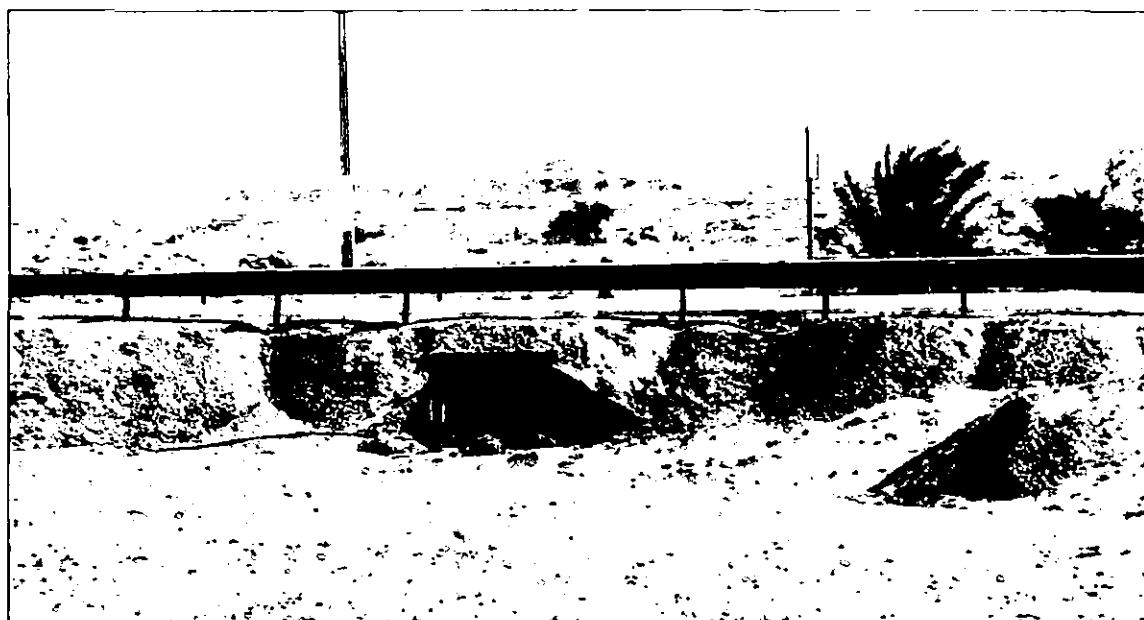
תמונה מס' 2. מעביר מ.מ.3 בקוטר 1.40 מטר בכביש 90. מבט משטח התכנית לכיוון בקעת הערבה (ממערב למזרח).
