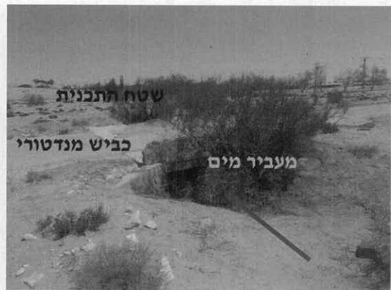
תמונה מספר 3 – מבט על מעביר מים בכביש מנדטורי (מ.מ.2) (מכיוון הלימן)
