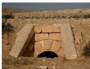
ה. מעביר מים קשתי, במקור של סוללת הרכבת התורכית
