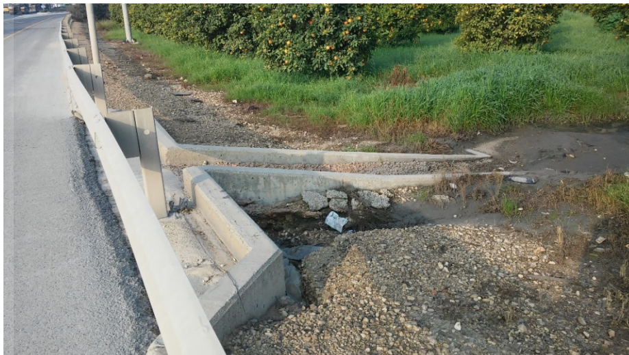
תמונה 3.1: פרט עקרוני מגלש למי נגר מהכביש לשטח
