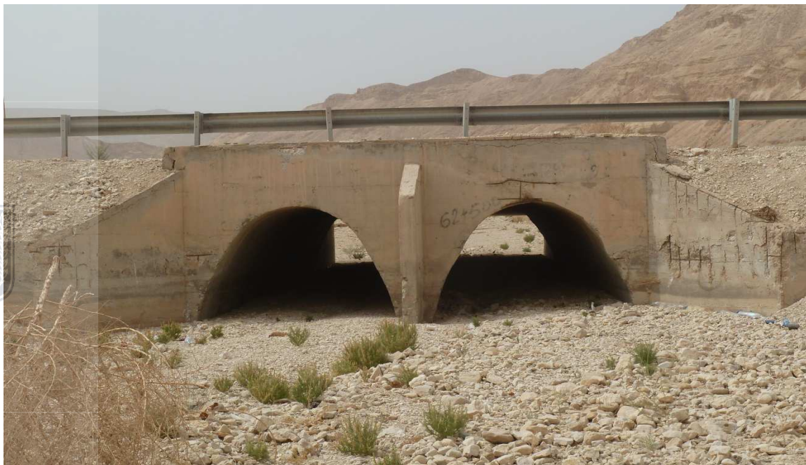
תמונה מס' 1 - נחל גרופית – מעביר מים בכביש 90 (מ.מ.1 בתרשים מס' 3).
