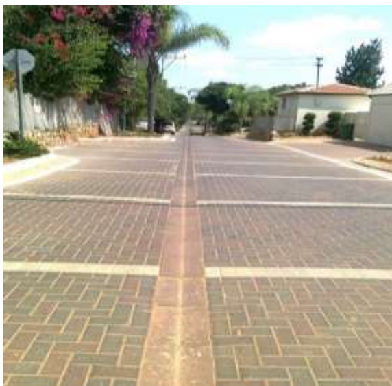
תמונה 3.2 : אבן תעלה (גאטר) בכביש פנימי לאיסוף והולכת נגר
