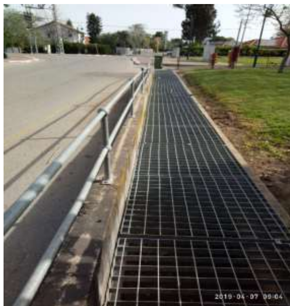
תמונה 3.3 : תעלת בטון מעוצבת קיימת ברחוב החלוץ
