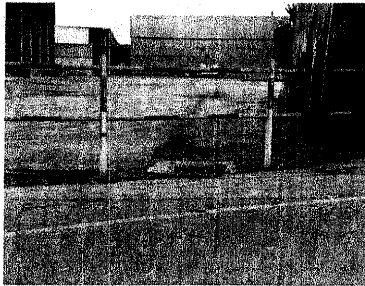
תמונה מס' 5 קולטן ניקוז בשטח - כמותו פזורים רבים, התכסית גגות ואספלט.
