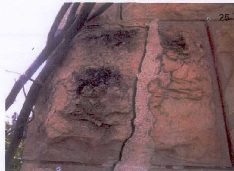
25. אבן סדוקה בחזית המזרחית כתוצאה ממאמצים שהופעלו עליה בזמן תזוזות המבנה
