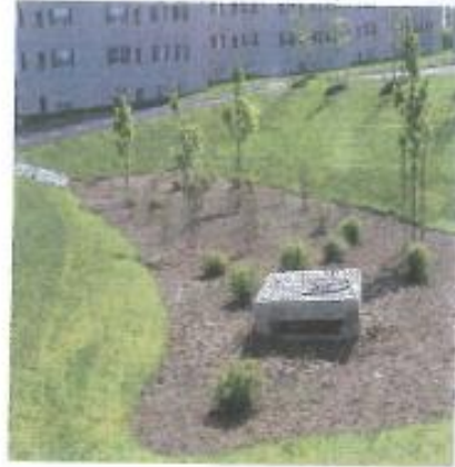
שיפור פסולת ההשהיה על ידי מתקן איסוף מים ממפלים מוגבה, והובלתם למערכת החדרה/או למערכת הניקוז העירונית.
