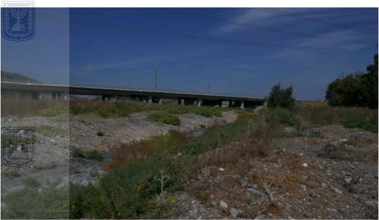
איור 5 מבט משולי שטח התוכנית לכיוון צפון- גשר כביש 6 על נחל הקישון ותעלת ניקוז
