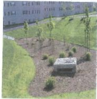
שיפור פשלת ההשהיה על ידי מתקן איסוף מים ממפלס מוגבה, והובלתם למערכת החזרה/או למערכת הניקוז העירונית.
