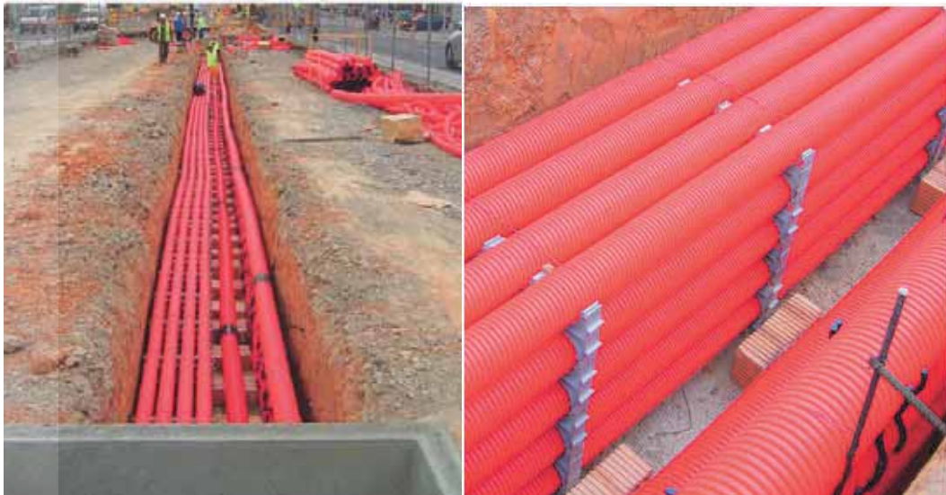
איור מס' 31: הנחת תשתית המולטיטובולר בעת ביצוע העבודות להקמת הקו
