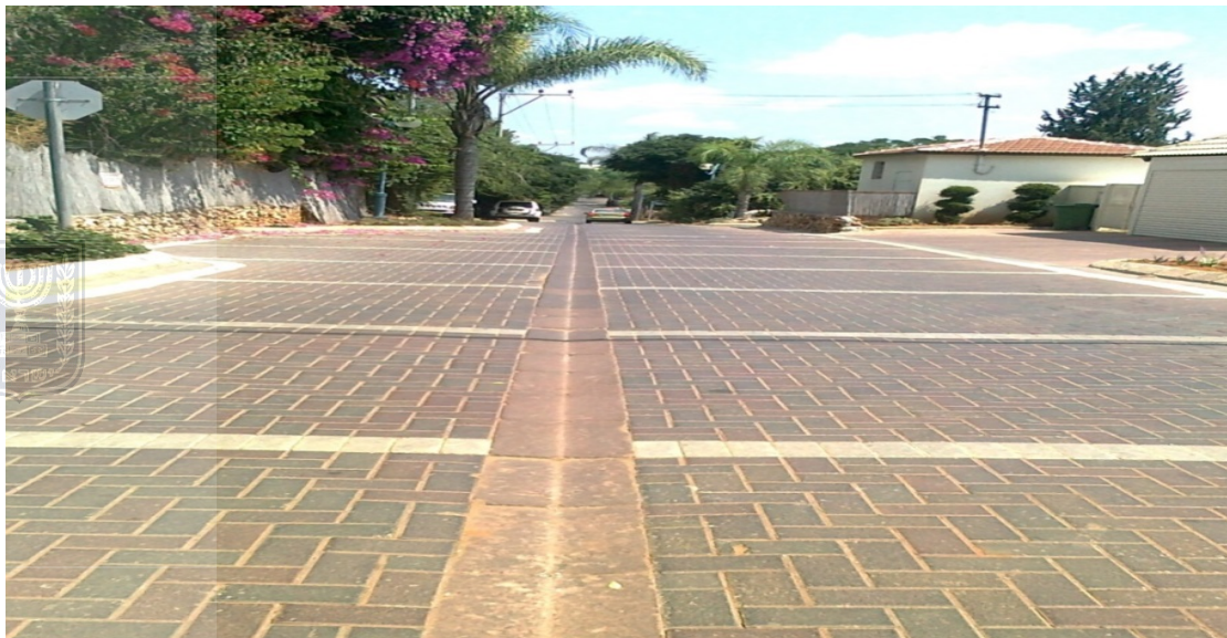
תמונה 3.1 - גאטר בכביש פנימי לאיסוף והולכת נגר.
