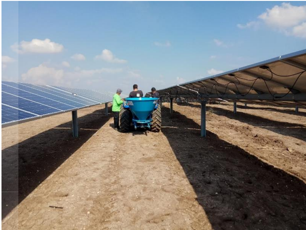
איור 6: זריעת צמחי כיסוי במתקן פוטו-וולטאי באמצעות מדשנת
