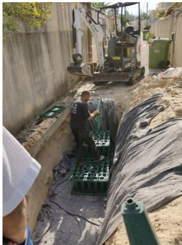
איור 6 - יישום מערכת יחידות השהיית נגר (Drain Blokes), מתחת למגרשי חניה ומשטחי אטימים
