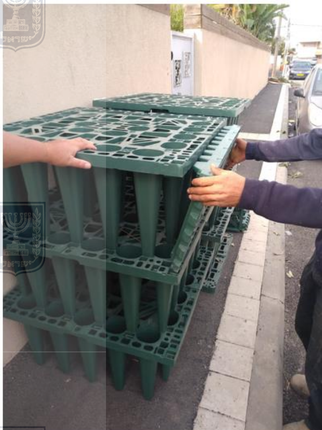
איור 6 - יישום מערכת יחידות השהיית נגר (Drain Blokes), מתחת למגרשי חניה ומשטחי אטימים
