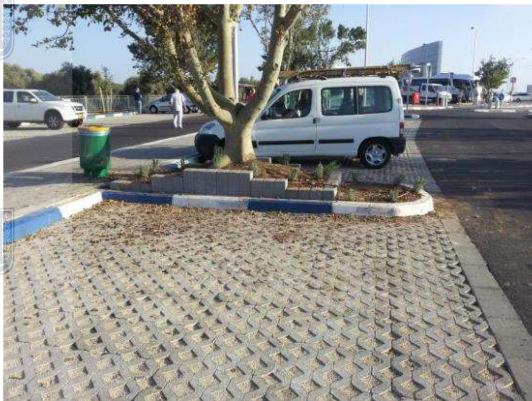
מגרש חנייה מחלחל, תחת הריצוף המחלחל מתוכנן אוגר למים ממולא חצץ ועטוף ביריעה גיאוסינטטית.
