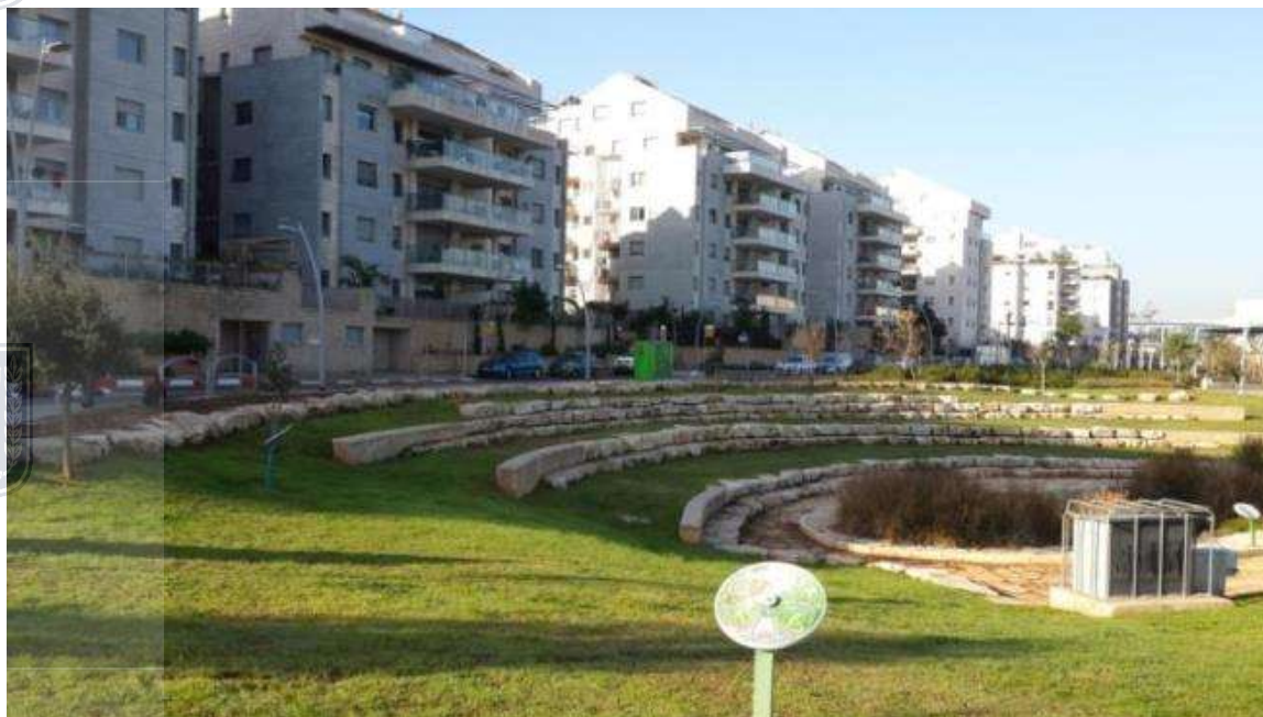
ביופילטר – אגן ירוק עירוני המטהר מי נגר מזוהמים ומחדיר אותם אל מי התהום
