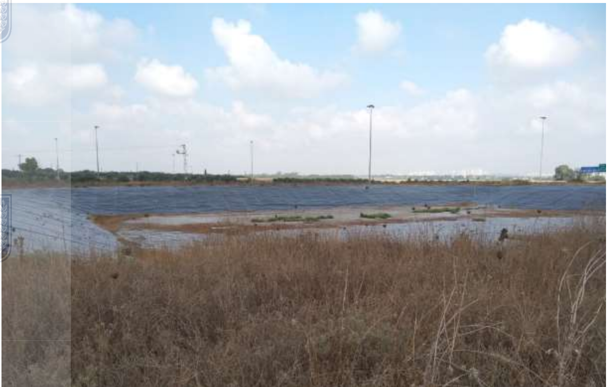
תמונה 2.1 מאגר קולחין נחשונים (חלק מזרחי ריק, יריעת האיטום בתחתית חשופה לחלוטין)
