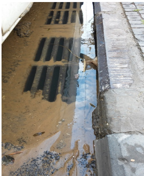
תמונה 2.3: פתח הניקוז בצומת רחוב המלאכה \ אורט ישראל, המים עומדים לאחר הגשם
