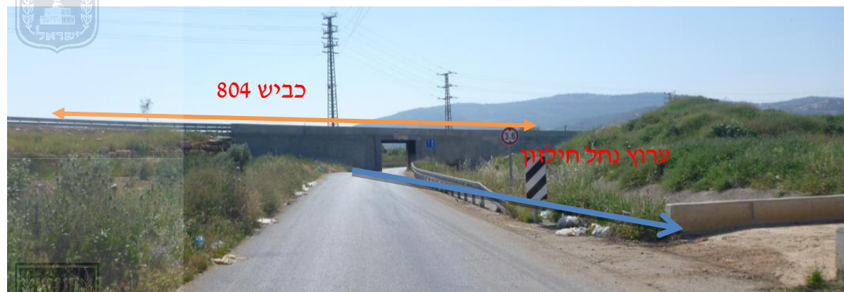
מבט מנחל חילזון, מזרחה, אל גשר כביש 805 הערוץ עובר בתעלת ניקוז כשרציפות אגן הנחל נחסמת בקירות בטון.
