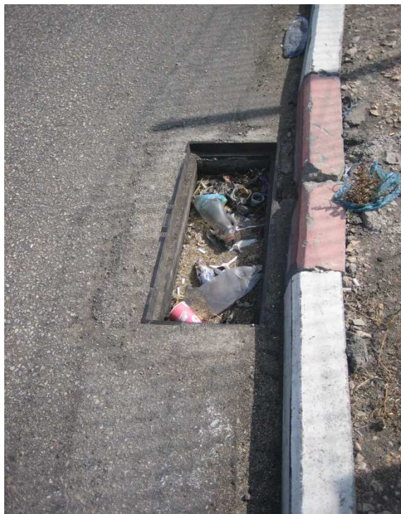
תמונה 3- קולטן סתום בכניסה הצפונית תמונה 4- תוואי ניקוז בכביש לכיוון מעביר המים
